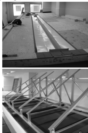
《無落雪屋根におけるソーラーパネル施工》 (模擬家屋②使用)
