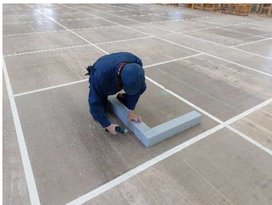
写真 2-7 ビス打ち込み状況
