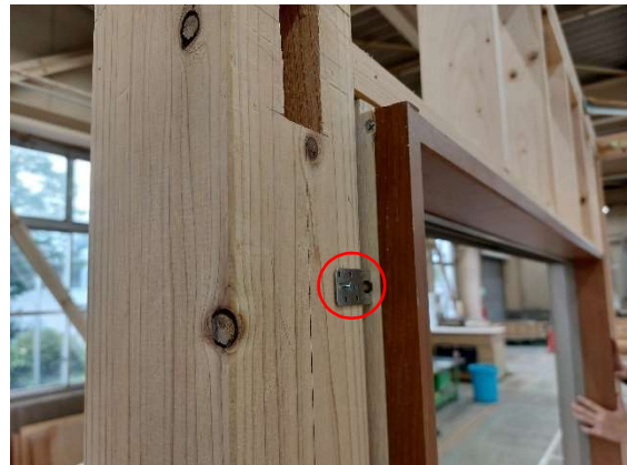
写真 14-14 窓枠取付金具 仮止め
