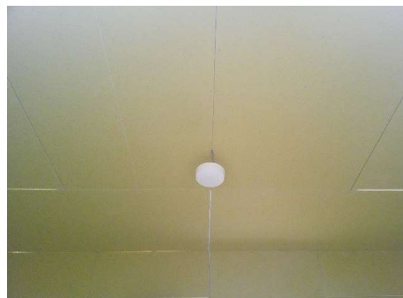
写真 16-7 天井石こうボード施工状況
