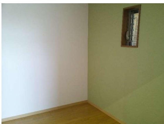
写真 18-4 室内クロス施工状況
