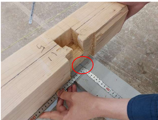
写真 3-16 52.5mm の線と土台側面の位置確認
