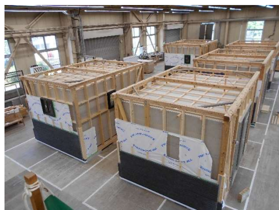
写真 19-2 外壁訓練の様子
