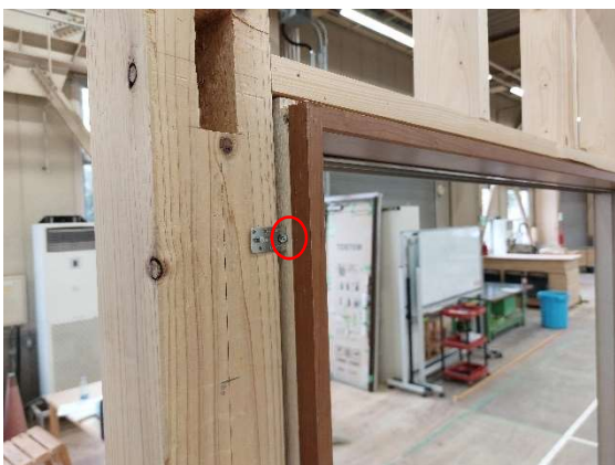
写真 14-15 窓枠固定金具と窓枠の固定
