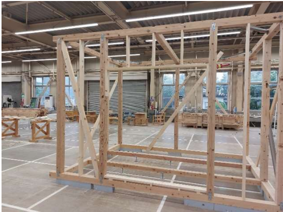
写真 11-26 間柱完了
