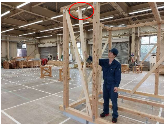
写真 9-23 短ほぞ差しの差し込み確認
