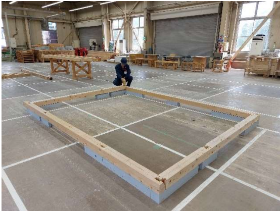
写真 3-18 土台の仮組み
