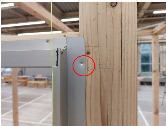
写真 11-45 サッシビス止め前
