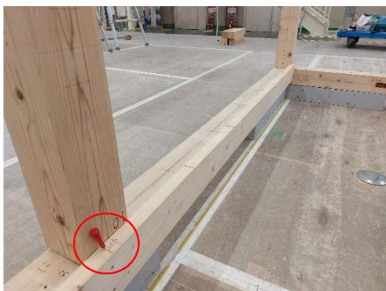
写真 12-9 根太側面の墨出し (1 本目)
