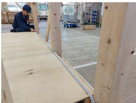
写真 13-1 部屋の中心出し
