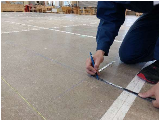
写真 2-1 通り芯から 52.5mm の印付け
