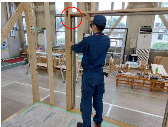
写真 14-2 H 寸法計測
