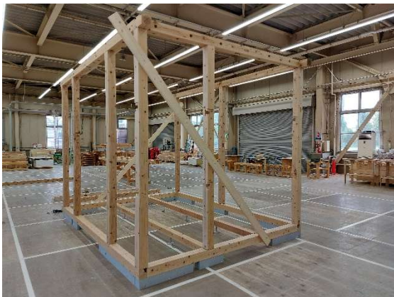
写真 6-6 に通り及び1 通り 建て方
