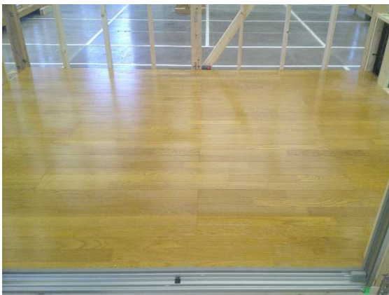
写真 13-34 フローリング 完了
