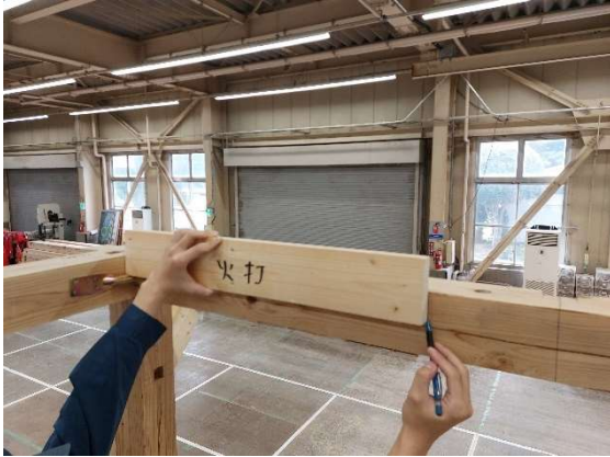
写真 7-9 定規による墨出し
