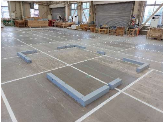
写真 2-11 基礎工事完了
