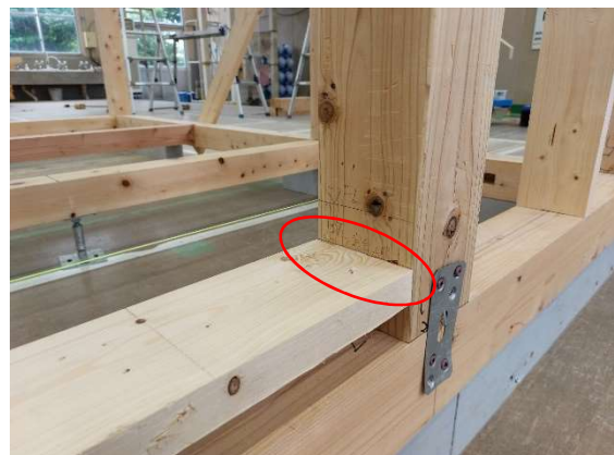
写真 11-5 窓台施工状況
