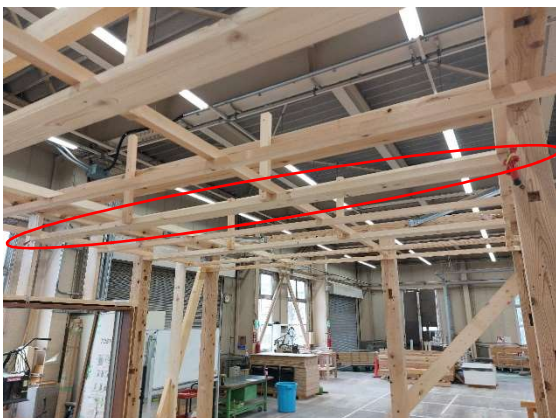
写真 15-17 天井むくり確認
