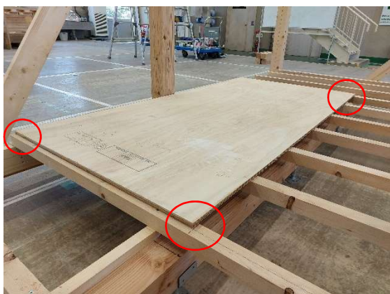
写真 12-26 墨合わせ状況
