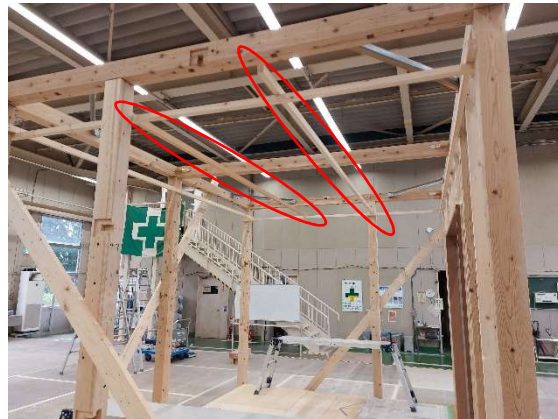
写真 15-11 野縁受け@910mm
