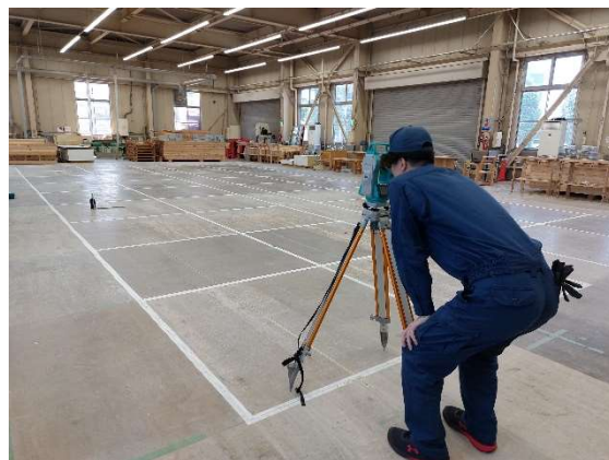
写真 1-2 トランシット確認状況
