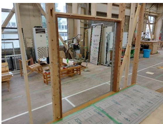
写真 14-23 窓枠設置完了
