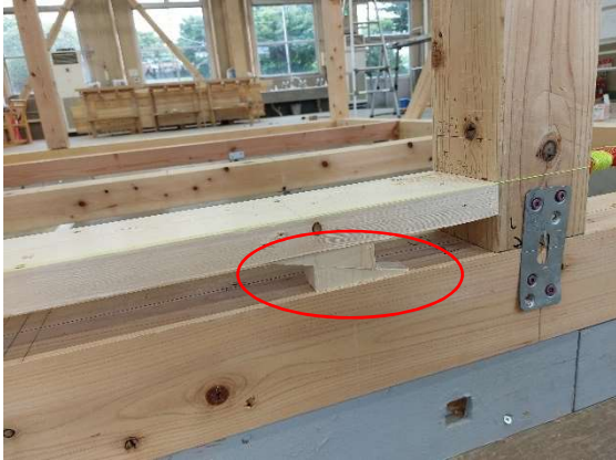
写真 11-8 窓台の高さ調整くさび
