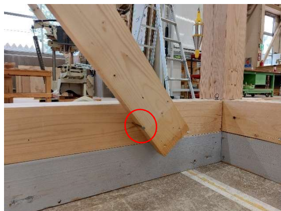
写真 7-7 釘を打つことで仮筋交いを浮かす
