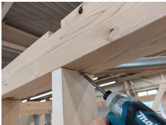
写真 9-11 ビスによる上部留め付け
