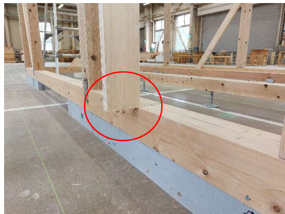
写真 9-6 短ほぞの肩の部分を上台にあてる
