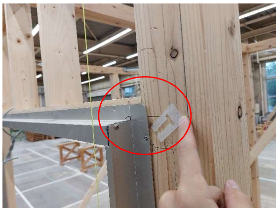
写真 11-49 サッシペーサー差し込み状況
