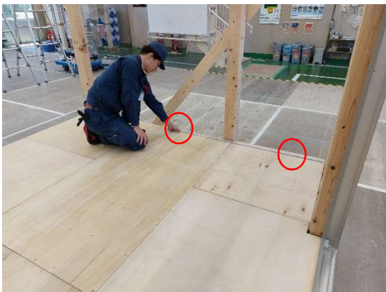
写真 13-11 部屋端部での印付け
