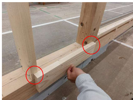
写真 12-2 端材を使い根太掛け下端の印出し
