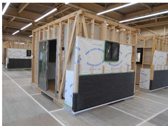
写真 19-1 外壁施工状況
