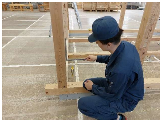
写真 7-5 下げ振りによる確認
