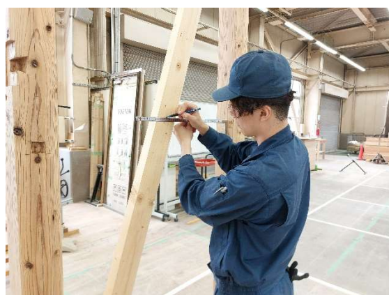
写真 9-14 筋交いに距離を転写する（2点）
