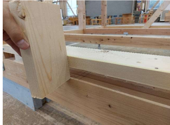
写真 11-9 間柱の現場合合わせ状況
