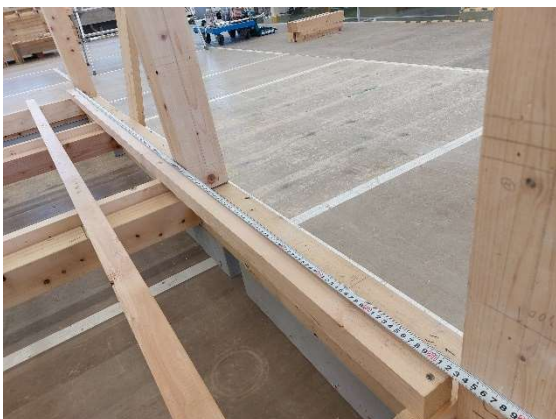
写真 12-14 部屋の中心出し
