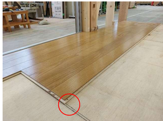
写真 13-30 墨合わせ状況
