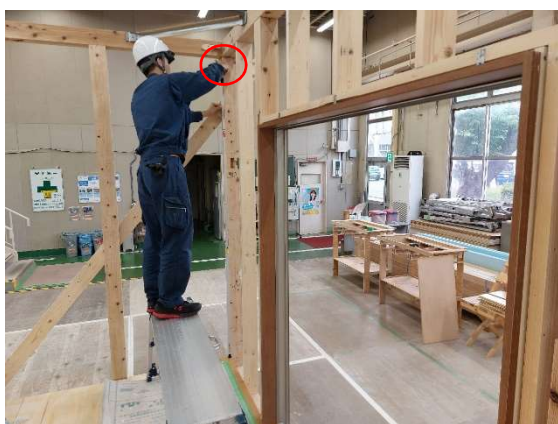
写真 15-3 柱への墨出し状況
