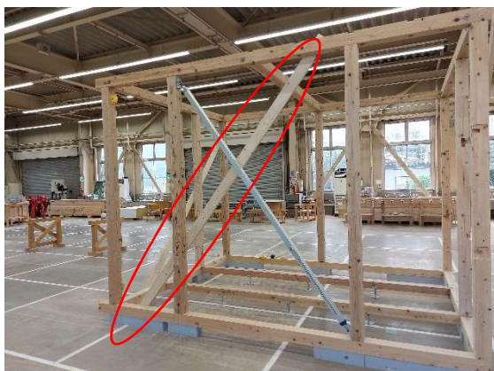
写真 7-8 仮筋交い施工状況
