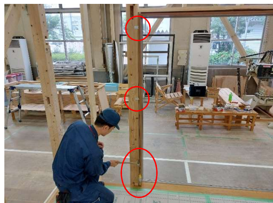
写真 14-18 窓固定金具と柱の固定
