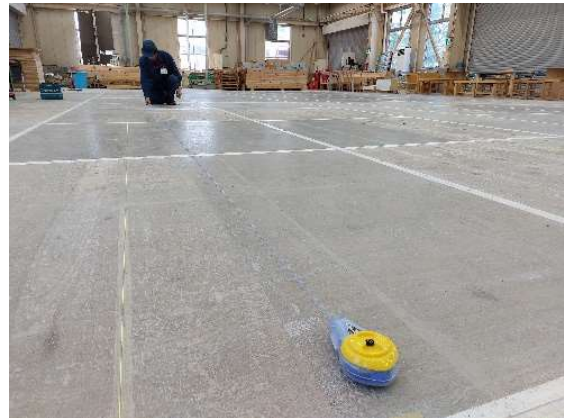
写真 1-6 チョークラインによる墨出し
