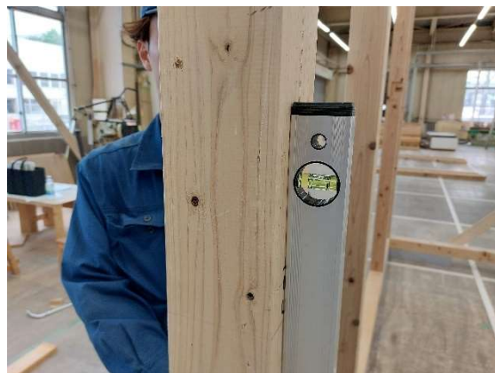
写真 6-4 柱の鉛直を確認
