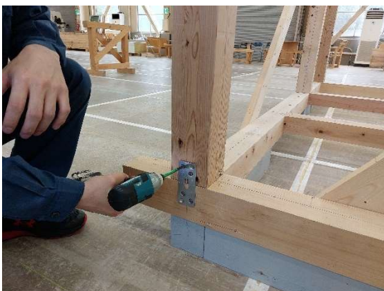
写真 7-11 柱用金物 施工状況
