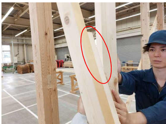
写真 9-19 材料で隙間を埋め、線を引く場合
