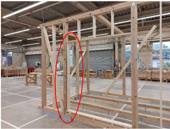
写真 11-33 方立の施工
