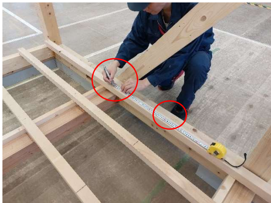
写真 12-22 部屋端部で 497mm の印付け
