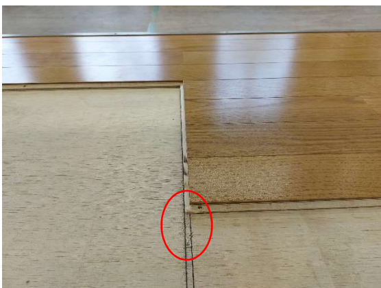
写真 13-31 右の線が部屋中心線（フローリング仕上がりの目地は部屋中心となる）
