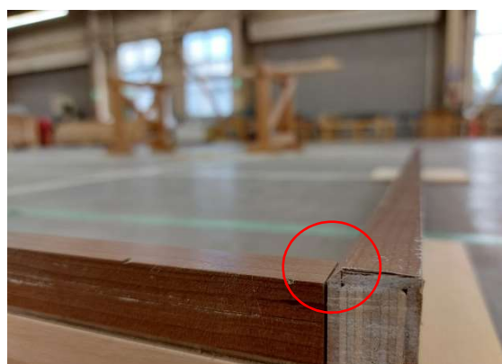
写真 14-8 3mm ベニヤ使用 (面下納め)
