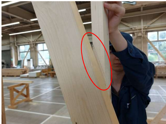
写真 9-17 外壁側から欠込み位置の線を引く
