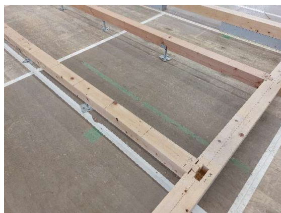
写真 6-2 大引き施工後
