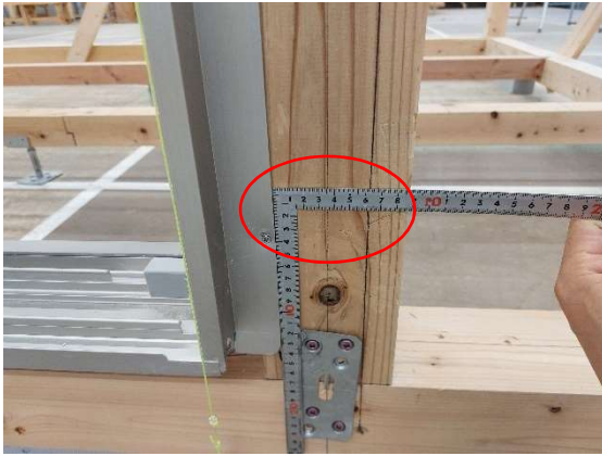
写真 11-43 サッシから墨までの距離
