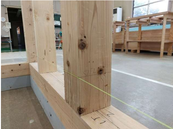
写真 10-5 間柱への墨付け
