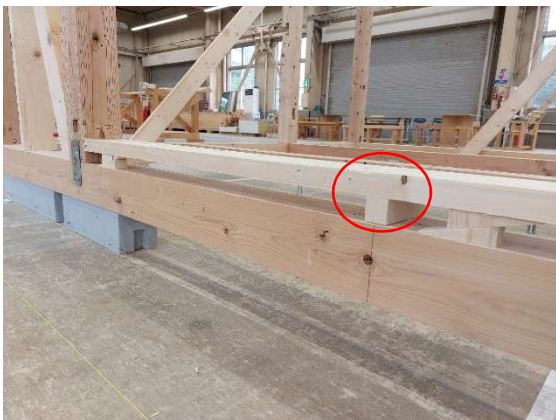
写真 11-10 間柱施工（たわみ改善）
