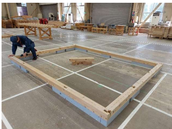
写真 3-24 土台留め付け
