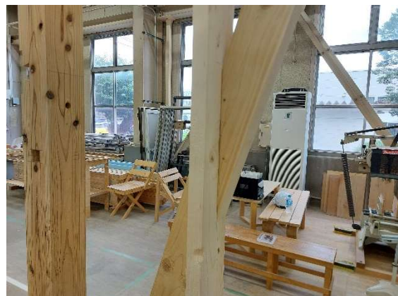
写真 9-26 筋交い部分の間柱完了
