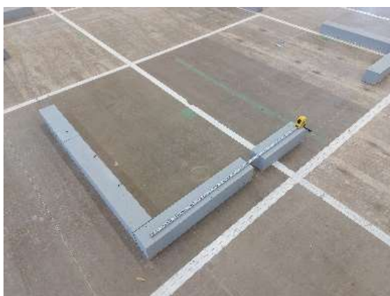
写真 2-9 ろの 1 基礎施工状況
