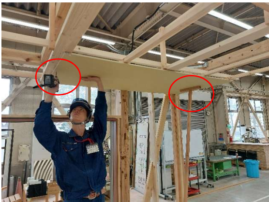
写真 16-6 天井石こうボード施工状況
