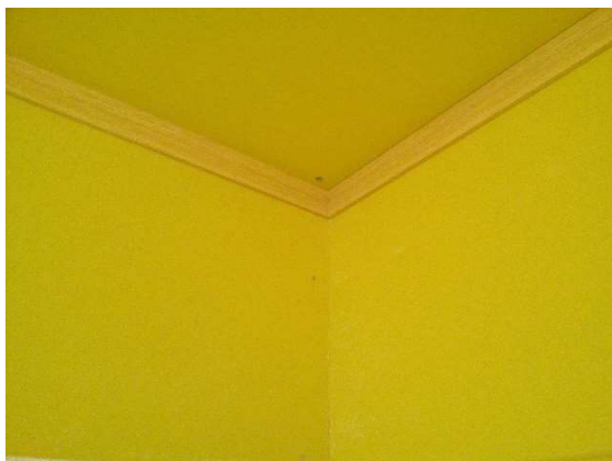
写真 17-1 天井廻り縁施工状況
