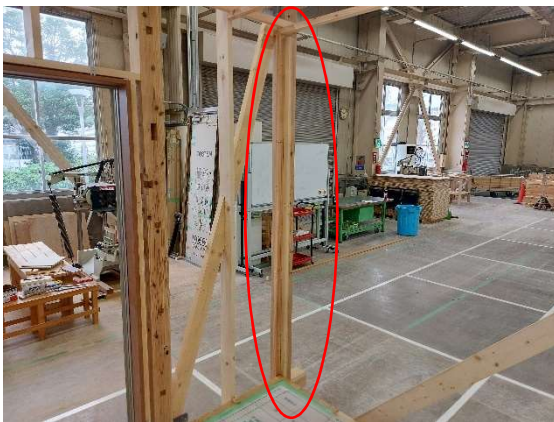
写真 16-1 ボード受け施工状況
