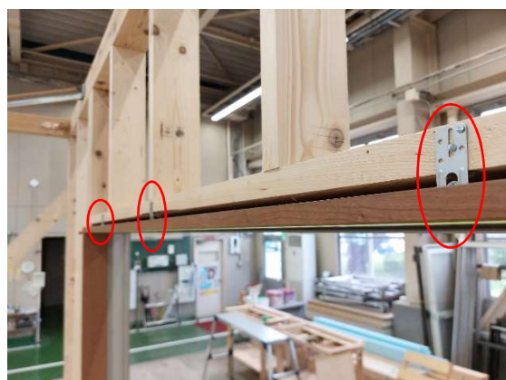
写真 14-22 窓枠の固定状況
