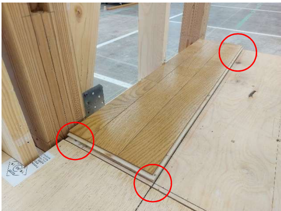
写真 13-20 フローリング 仮置き
