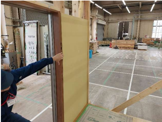
写真 16-3 壁石こうボード施工状況
