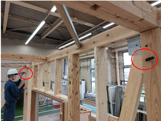
写真 15-5 間柱への墨出し状況
