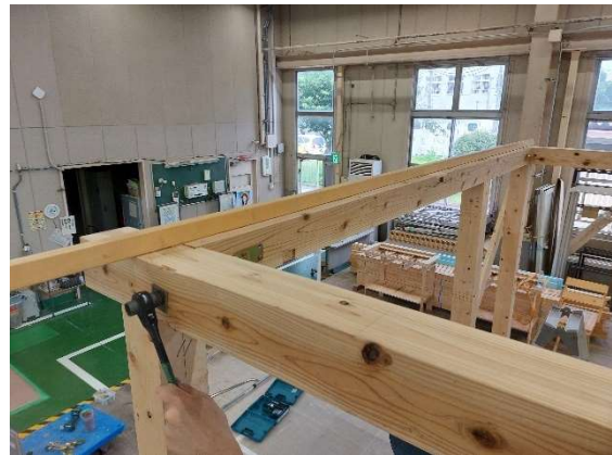
写真 7-2 ラチェットレンチによる締め付け
