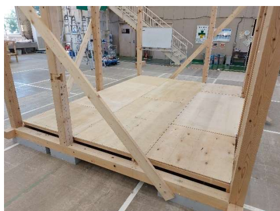
写真 12-31 床下地仮置き後
