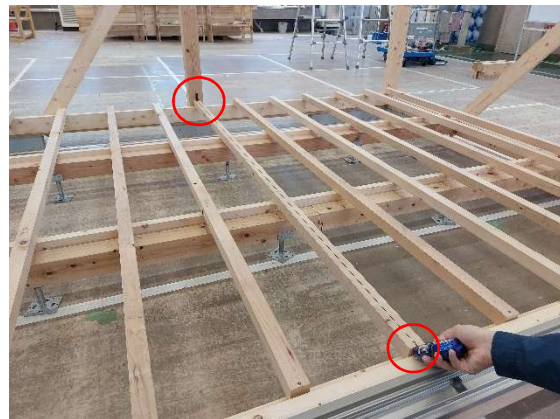
写真 12-17 部屋中心の墨出し(桁行方向)
