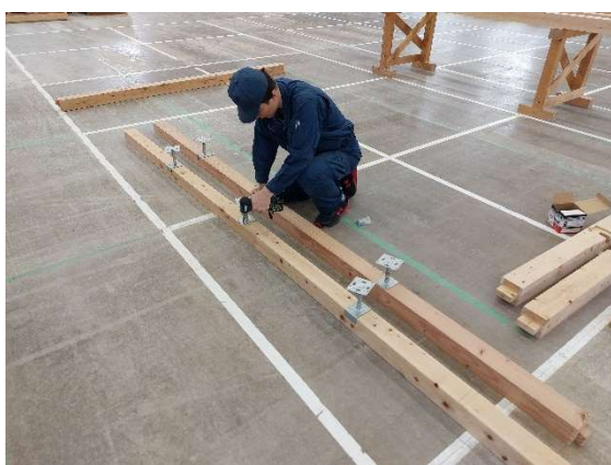
写真 6-1 鋼製床束取り付け
