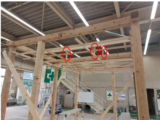
写真 15-14 吊り木 施工状況
