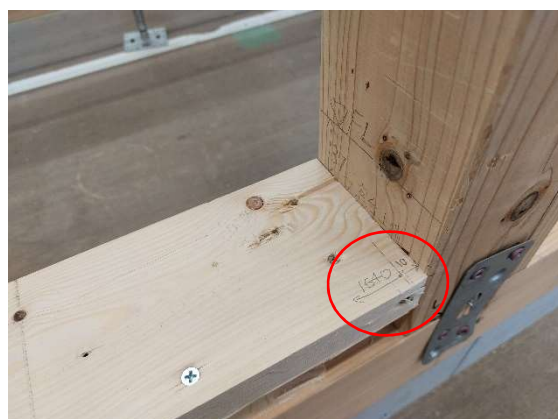
写真 11-40 窓台天端への線引き
