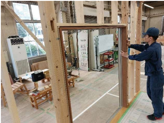
写真 14-13 窓枠仮止め
