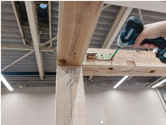
写真 7-1 羽子板ボルト 施工状況
