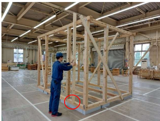
写真 9-5 短ほぞを下に向け長さを計測
