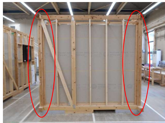
写真 16-2 ボード受け施工状況
