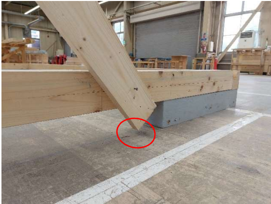
写真 6-5 建て方用仮筋交い取り付け
