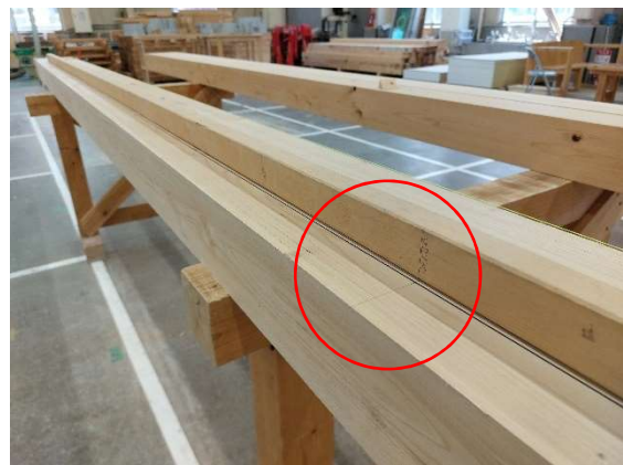
写真 3-9 尺杖による印付け
