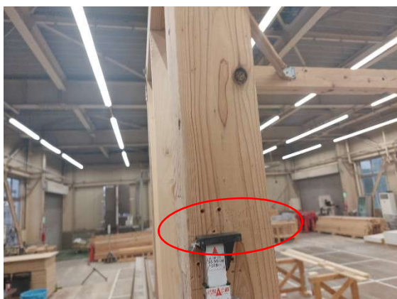
写真 11-16 窓まぐさ下端の墨出し
