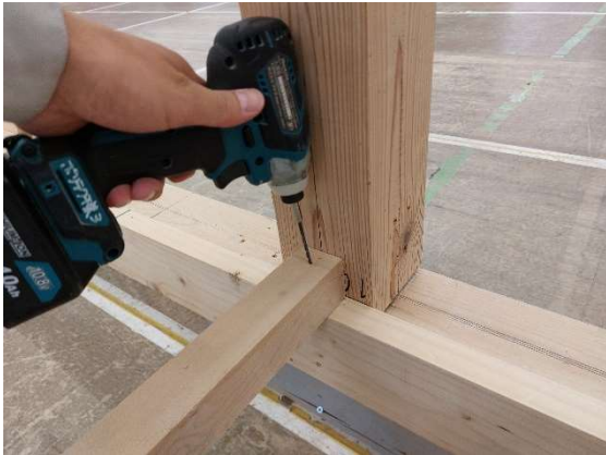
写真 12-11 根太の下穴開け
