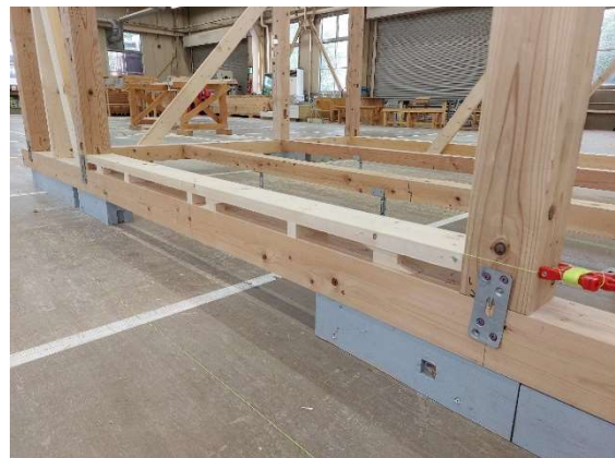
写真 11-11 間柱施工完了
