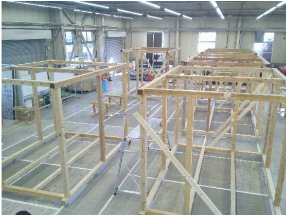
写真 6-8 実際の建て方訓練状況（5 グループ制）
