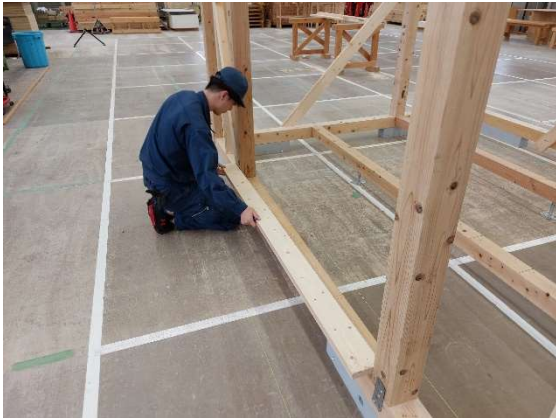
写真 11-2 窓台の現場合わせ状況
