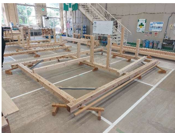
写真 22-1 小屋束加工状況
