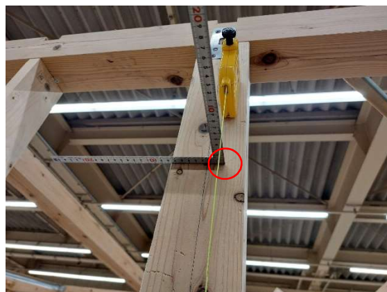
写真 11-38 柱への印付け
