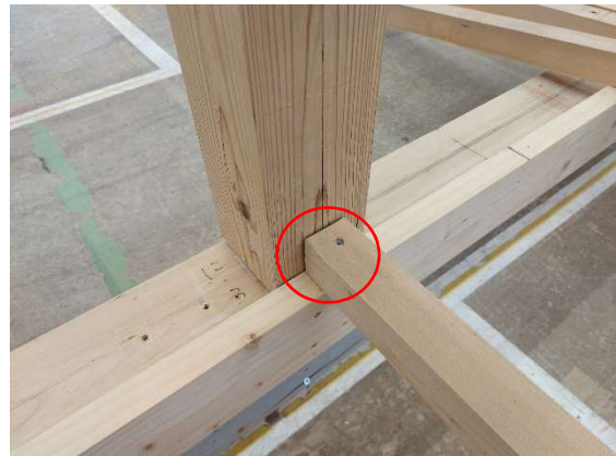
写真 12-12 根太のビス止め
