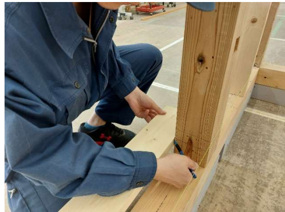
写真 11-3 窓台の墨付け
