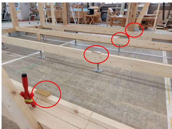
写真 12-7 板材の設置状況
