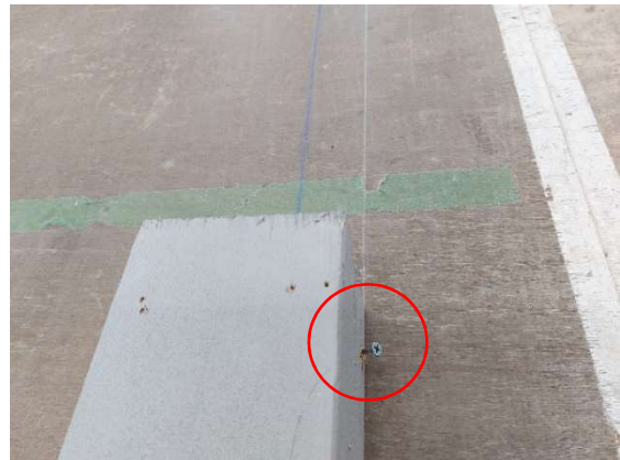
写真 2-4 1 本目は全部打たない
