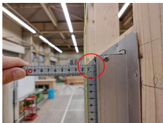
写真 11-50 サッシと下げ振りの距離 13mm
