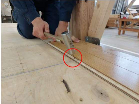
写真 13-23 釘打ち 根太の墨（青線）狙い
