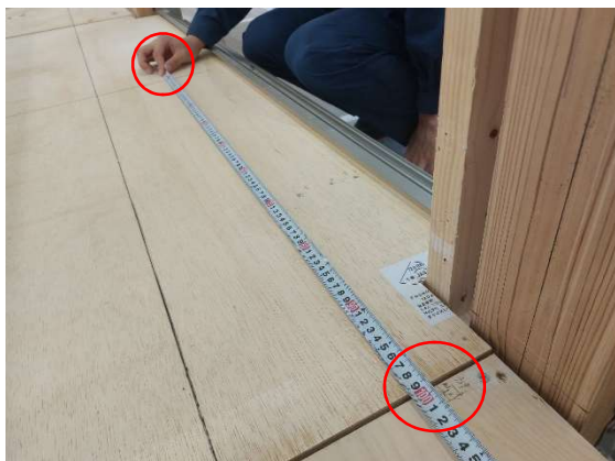
写真 13-14 部屋中心から 909 mm の墨出し
