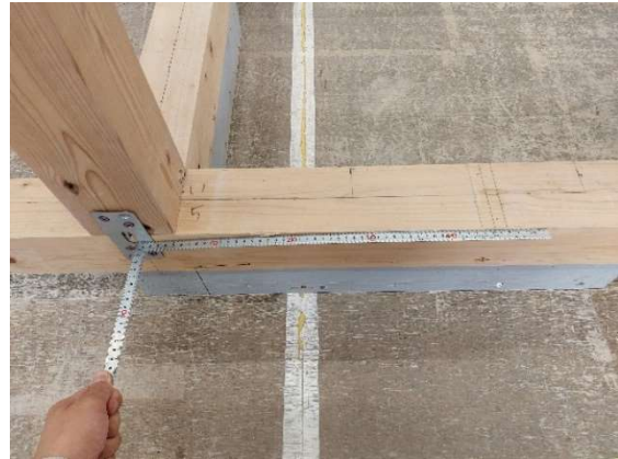
写真 9-2 間柱位置の墨出し
