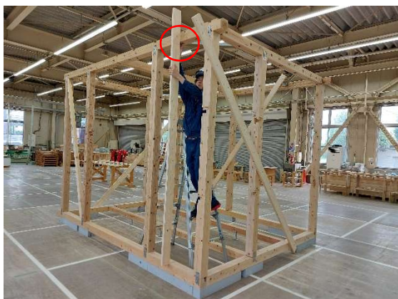
写真 9-7 長さの現場合わせ状況
