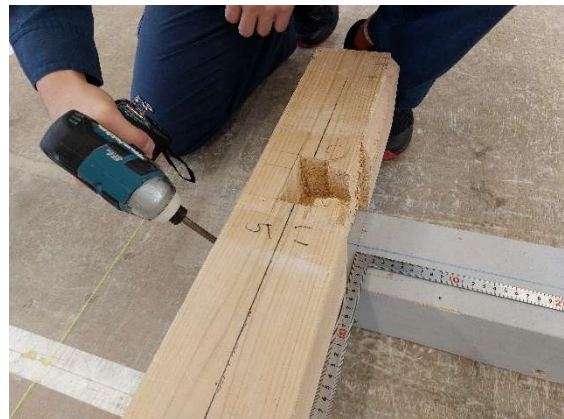
写真 3-17 ビスによる留め付け
