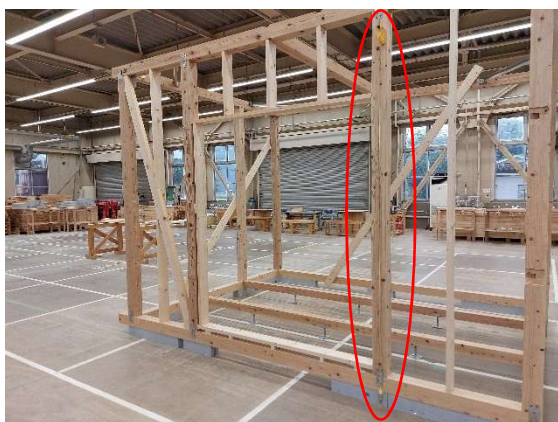
写真 11-37 下げ振り使用状況
