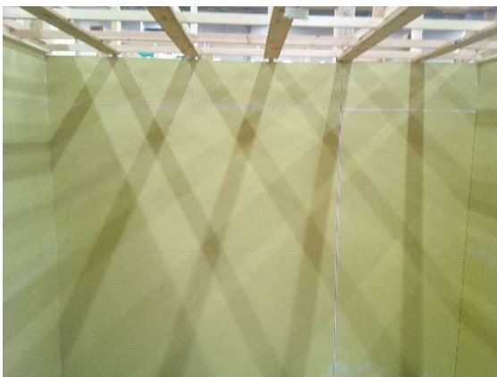
写真 16-5 壁石こうボード施工状況
