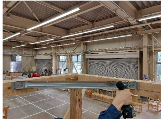
写真 7-10 火打ち金物 施工状況
