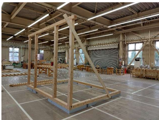
写真 6-3 い通り 建て方
