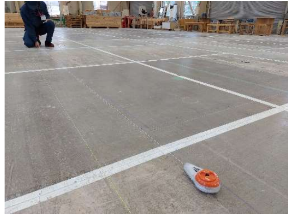
写真 2-2 チョークラインによる墨出し
