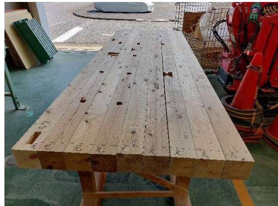
写真 5-2 長さ寸法に切断
