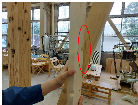
写真 9-16 間柱側面の墨出し完了
