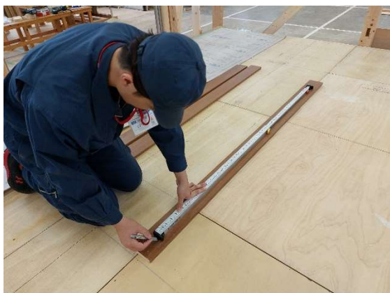
写真 14-4 枠材に印付け
