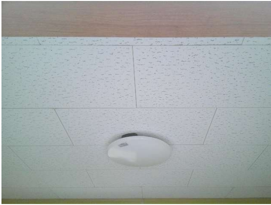
写真 16-8 化粧石膏ボード施工状況
