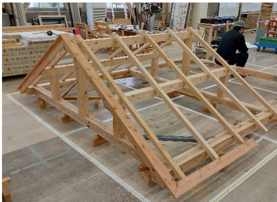
写真 22-3 屋根施工終了
