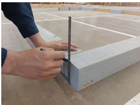
写真 3-12 通り芯 立ち上げ
