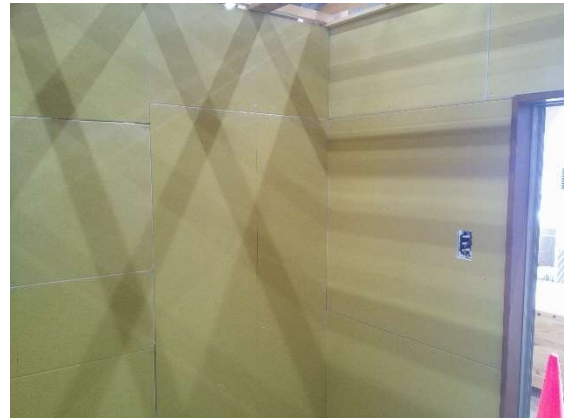
写真 16-4 壁石こうボード施工状況
