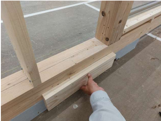
写真 12-3 根太掛け端材の取付
