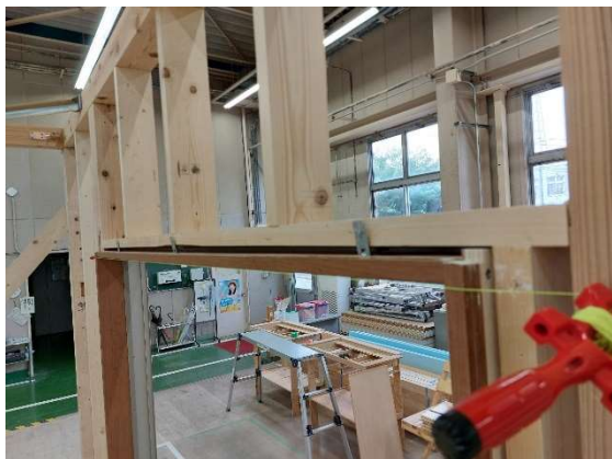
写真 14-19 水系によるむくりの確認
