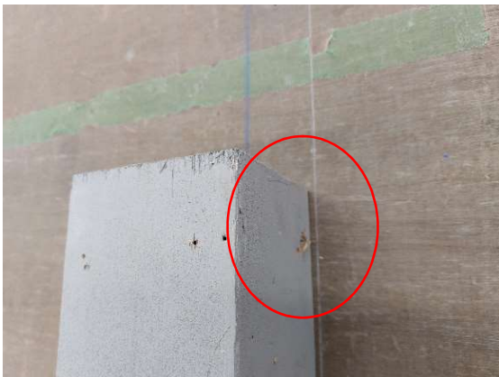
写真 2-3 ビスを 1 本目を全部打ち込むとズレる
