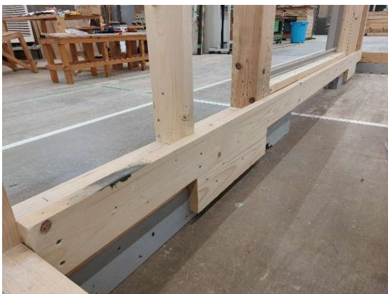
写真 12-5 根太掛け施工
