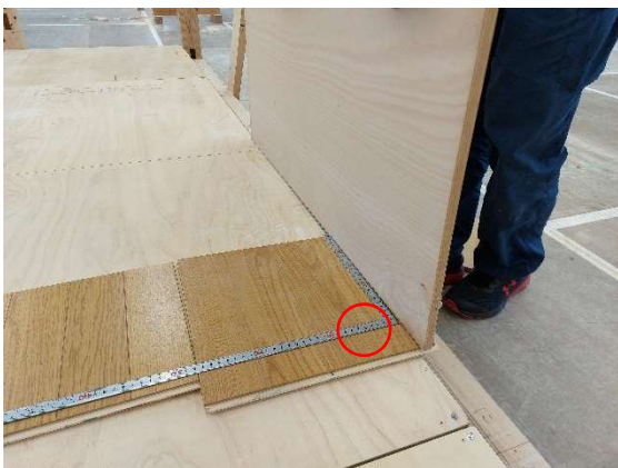
写真 13-7 壁から 48mm (5 通りの壁)
