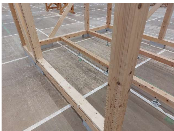
写真 11-39 窓台天端の状況
