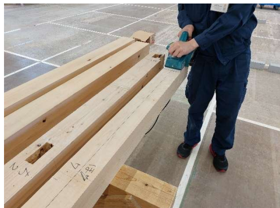
写真 3-2 旧材の電気鉋使用状況
