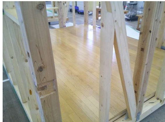
写真 13-33 フローリング 完了
