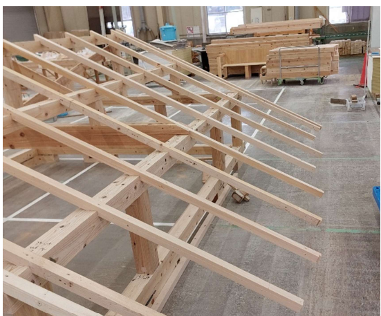
写真 22-4 屋根施工状況
