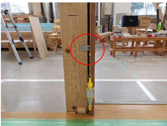
写真 14-17 鉛直度の確認
