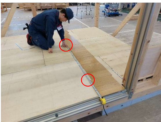
写真 13-8 1 枚前雄実までの距離
