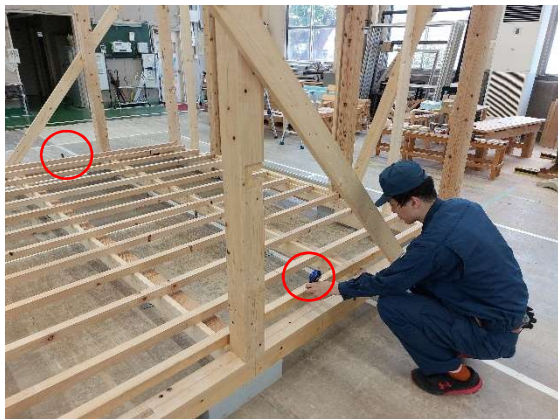
写真 12-16 部屋中心の墨出し(梁間方向)
