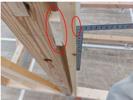
写真 11-35 くさびを使ったたわみ修正
