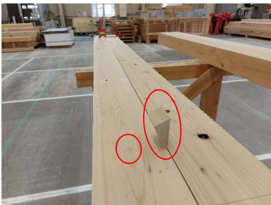
写真 3-7 左：中点水系通過状況 右：くさびにより調整
