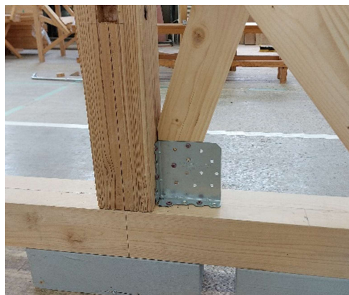
写真 8-9 筋交いプレート取り付け
