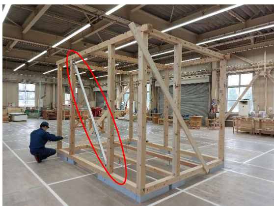
写真 7-6 歪み直し器具による調整
