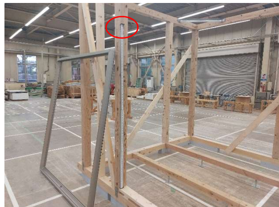
写真 11-15 窓まぐさ下端の墨出し
