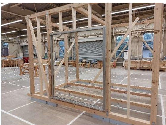
写真 11-51 サッシ完了
