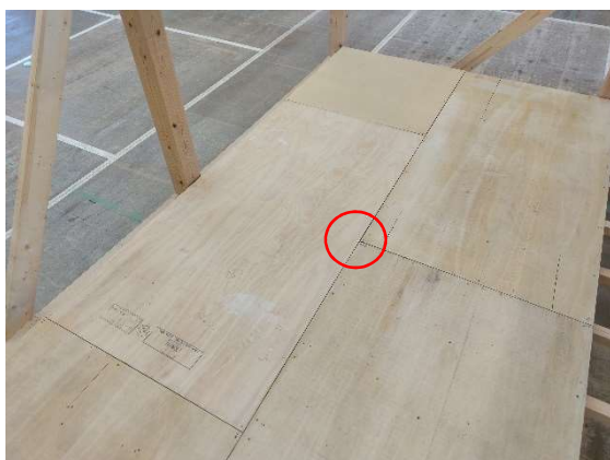
写真 12-30 隙間と目地分散
