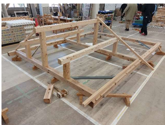
写真 22-2 棟木、母屋、桁の加工状況
