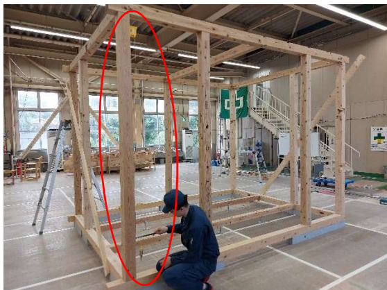
写真 7-4 下げ振りによる鉛直度の確認
