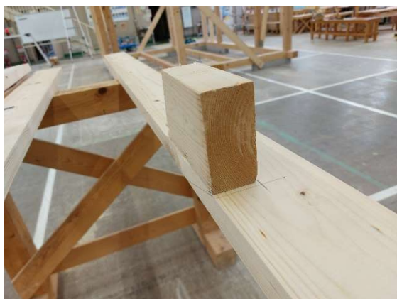
写真 9-20 筋交いの端材で厚み確認
