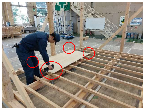
写真 12-27 4角の仮止め状況
