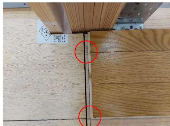
写真 13-21 墨に雄実の先端を合わせる
