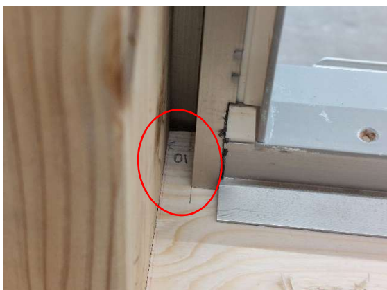
写真 11-41 部屋内から見た状況
