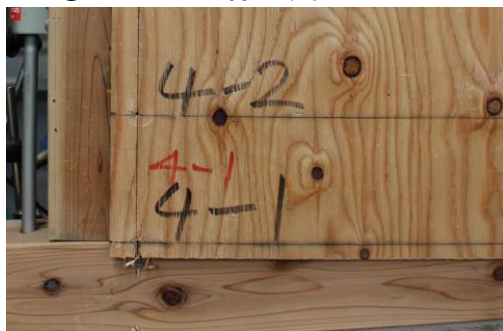
②釘のパンチング状況 ※P 120 は特定変形角1/120radを示す。
