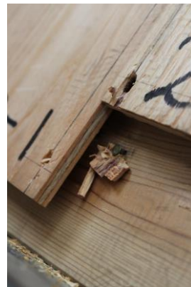
③ 面材の割裂破壊の状況
