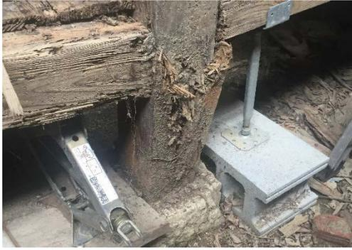
図4 床組み補強の様子
