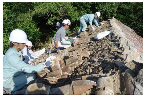
図 16 瓦撤去作業の様子
