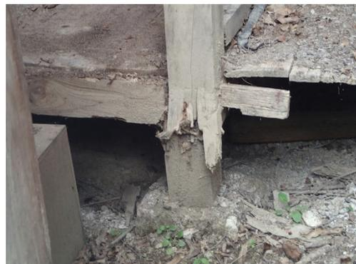
図3 柱の腐朽状況
