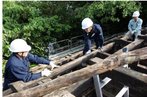
図 24 小屋組み寸法測定の様子
