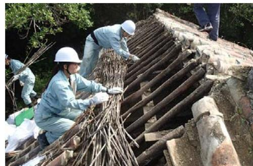
図 18 野地竹の撤去作業の様子
