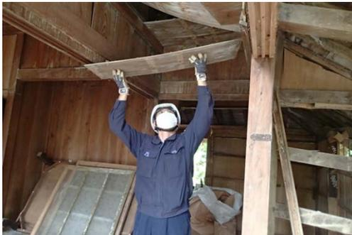
図 11 天井板撤去の様子
