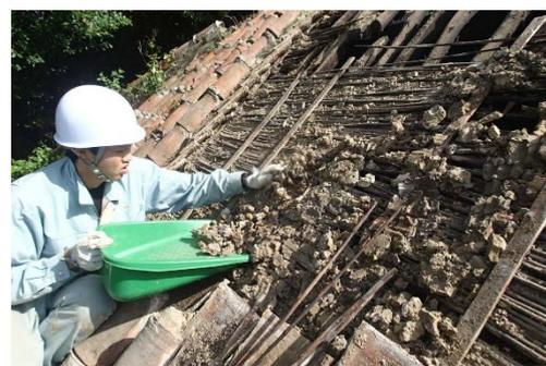
図 17 葺き土の撤去作業の様子
