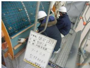
写真10 蓋型枠現場確認
