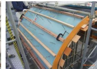
写真11 型枠施工後
