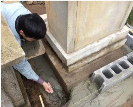
図 4 コンクリートブロックの据え付け
