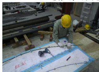
図 17 縦筋加工
