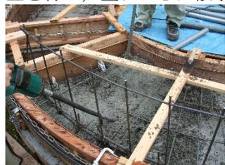
図 15 締め固め
