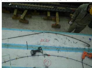
図 18 原寸図での確認
