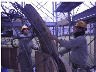
図 27 型枠建て込み
