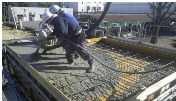
図 6 躯体打設状況
