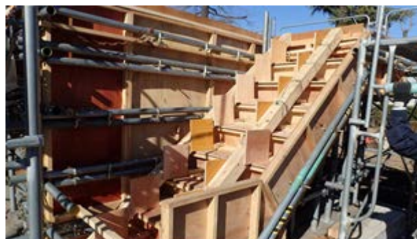
図 4 階段型枠設置完了
