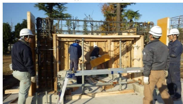
図 3 躯体型枠建込み状況
