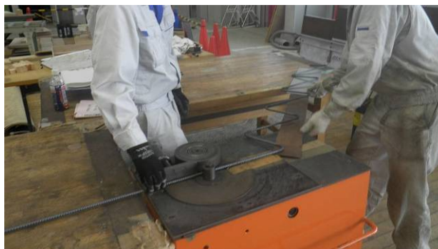
図 2 階段鉄筋加工状況
