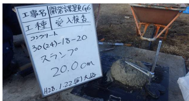
図 7 スランプ試験の状況
