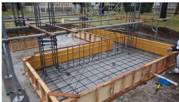
図 1 基礎型枠・柱主筋配筋状況
