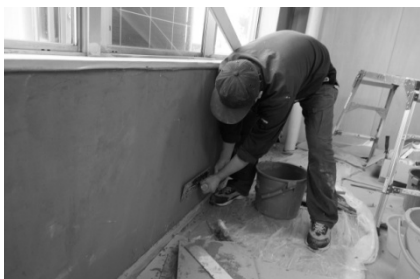
図 6 珪藻土壁工事
