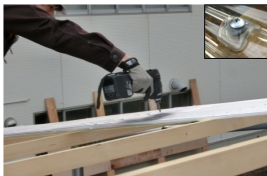
図 5.3 ポリカ波板の施工(1 次施工)
