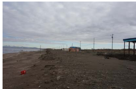
図 4.3 「海の家」解体撤去の状況 (2015年11月12日撮影)
