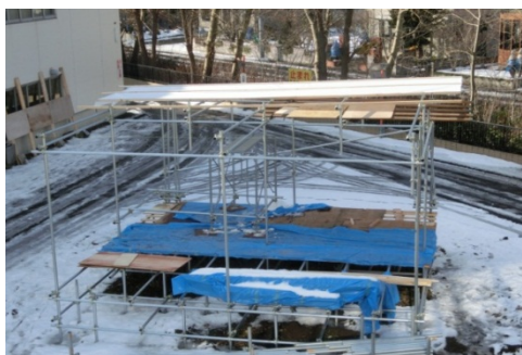
図 5.8 屋根勾配の変更と 木製足場板の設置(2次施工)
