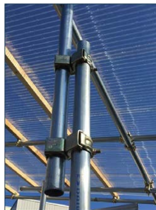
図 5.2 自在クランプによる高さ調節
