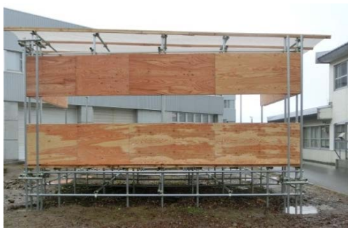
図 5.10 完成した2次施工モデル (2015年12月17日撮影)
