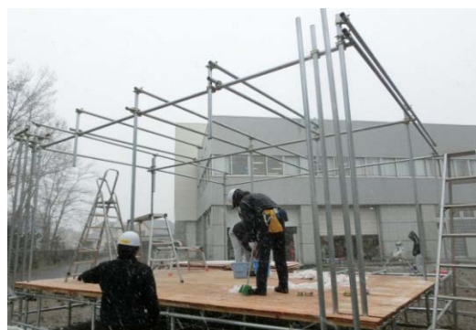
図 5.7 組柱への変更 (2 次施工)
