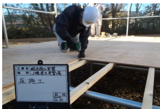
図 5.4 床の施工(1 次施工)
