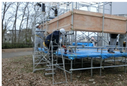
図 5.5 壁の施工(1 次施工)
