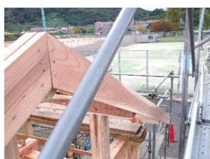
図 28 破風板取付け
