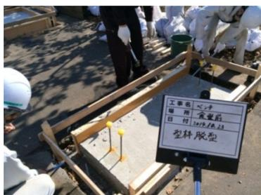
写真4 型枠脱型
