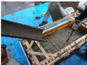
写真3 コンクリート基礎打設
