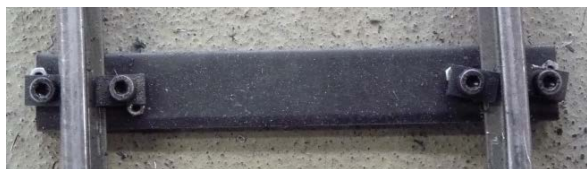
図6 曲線レールの枕木部
