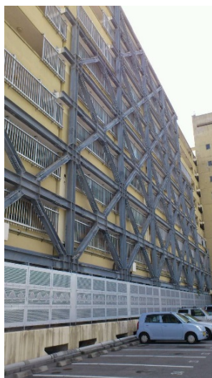
写真1 古波蔵市街地住宅の耐震補強事例
