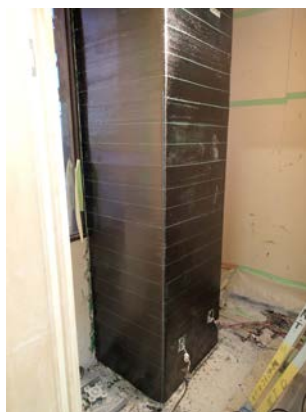
写真2 沖縄国税総合庁舎の耐震改修
