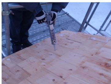
写真 25 設置箇所下穴へのコーキング
