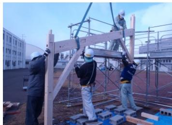
写真 18 妻梁・軒桁の設置
