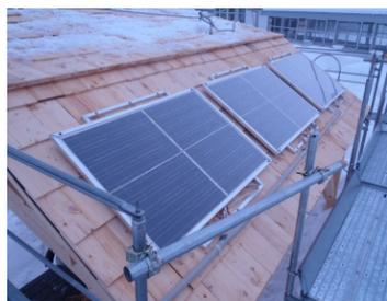
写真 26 太陽光パネルの取付け
