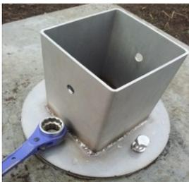
写真 17 柱脚金物の設置
