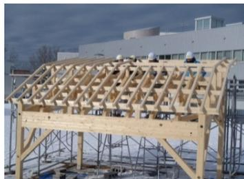
写真 20 軸組の組立状況
