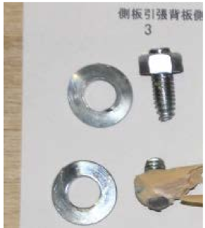
写真 6-3 アンカーボルト(8φ)の破断
