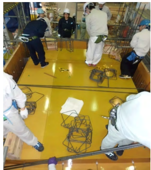
図 2 梁配筋の様子
