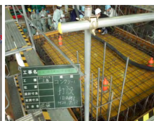
図7 コンクリート打設
