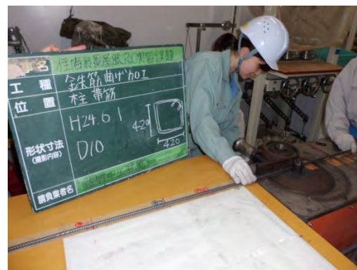
図 1 鉄筋曲げ機で主筋加工する様子
