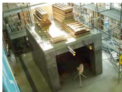
図 1 1 階型枠解体後の躯体(定点より)
