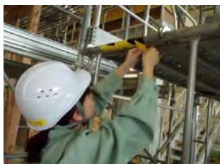
図4 トラテープ貼り付け
