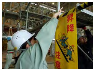
図5 安全標識取り付け
