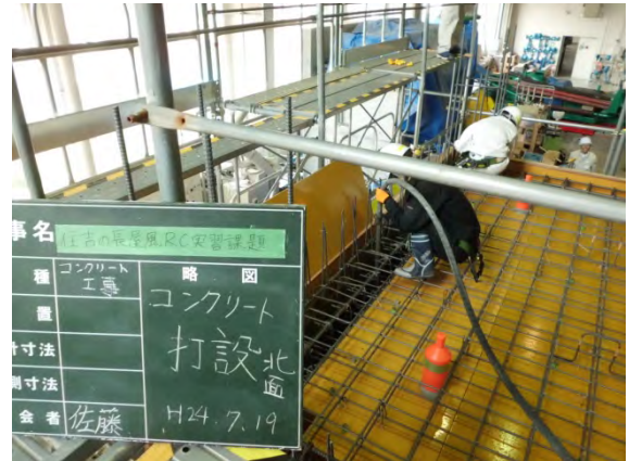
図3 コンクリート打設の様子
