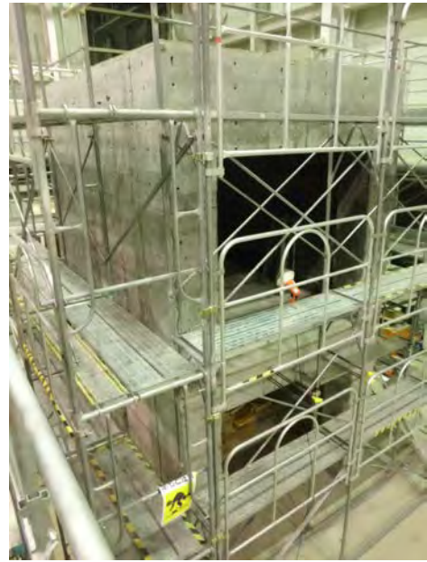
図2 後で施工した2階部分
