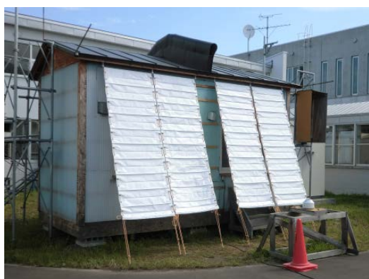
写真 2.5.3 日射遮蔽装置を設置した実験棟
