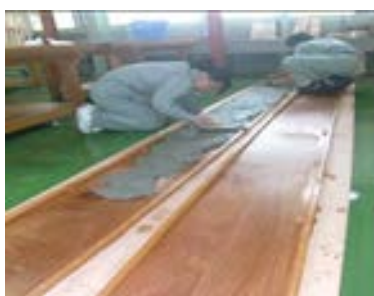
図6 モルタル打設
