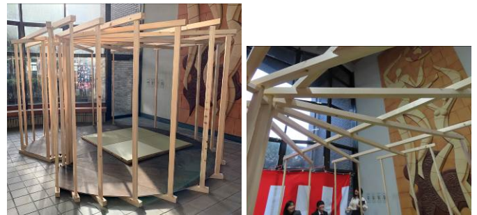
図7 組立完成の様子
