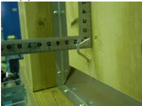
(e) 釘の引き上がり
