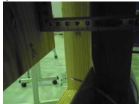
(f) 構造用合板の浮き
