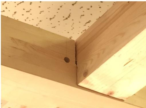
図 16 羽子板ボルトの穴の開け損じ
