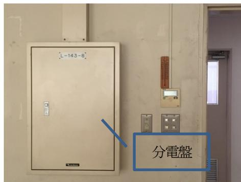
図8 壁面の分電盤
