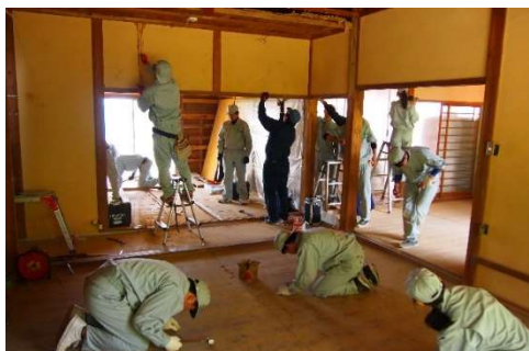
図 2 空き家の改修
