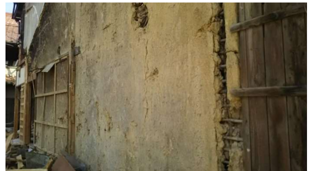
図 24 再利用した古民家の土壁
