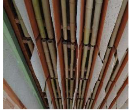
図 18 天井の仕上げ
