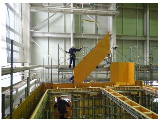
図 3-5-5 階段外側手摺型枠の先組み工法
