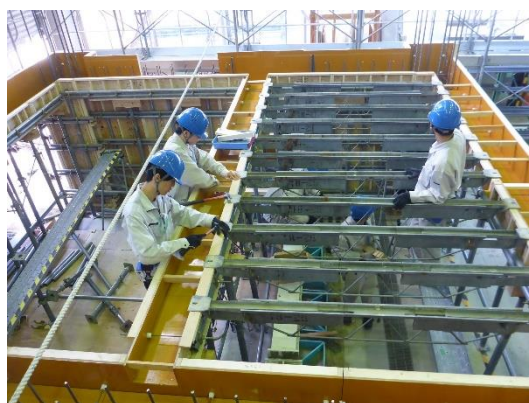
図 3-5-2 型枠支保工での支保梁工法
