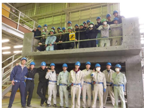
図 3-2-1 平成 29 年度 RC 構造躯体工事 1 階立上り 2 階スラブ完成後
