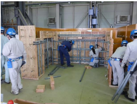
図 3-1-3、図 3-1-4 II 期の標準課題実習の型枠工事 平成 29 年度
