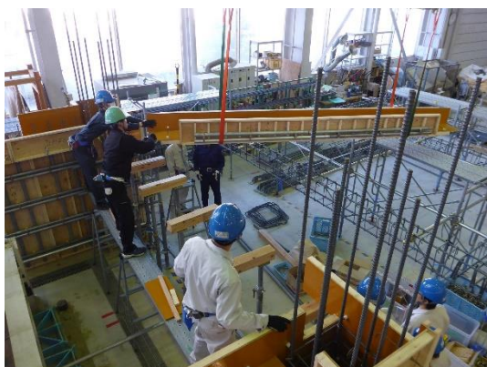
図 3-5-1 梁型枠の先組み工法
