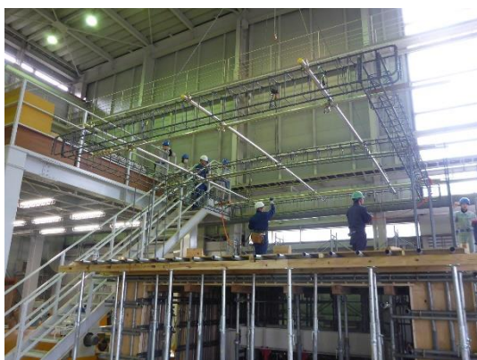
図 3-5-3 梁鉄筋の先組み工法
