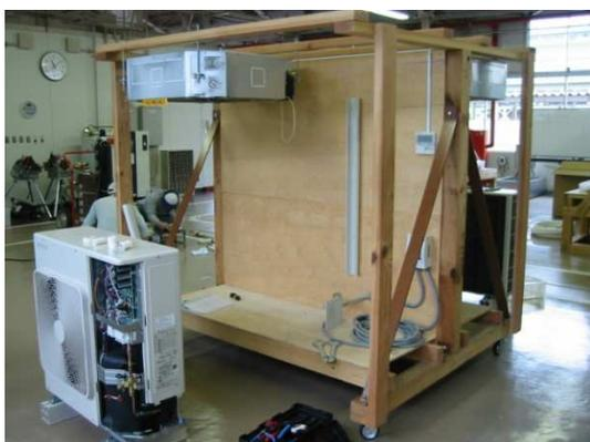
室内機の吊下げ（天井カセット形）
