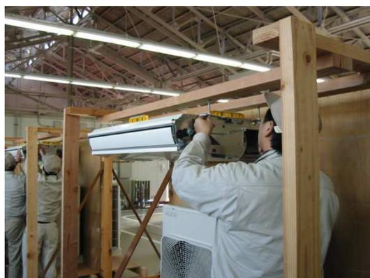
室内機の水平調整（天井吊形）
