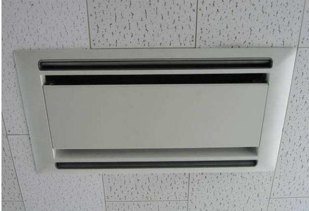
写真 3-1 天井埋込カセット形
