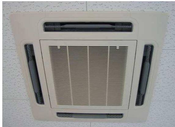
写真 3-2 天井埋込カセット形
