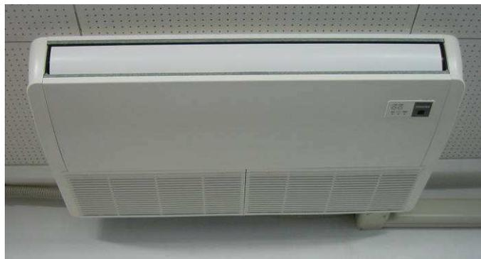
写真 3-3 天井吊形エアコン写真
