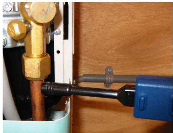
写真8-4 ガス側配管温度測定
