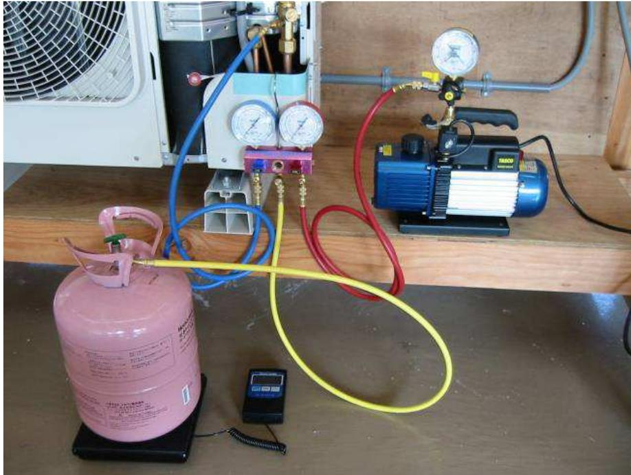
写真 6-1 冷媒充填時の接続例
