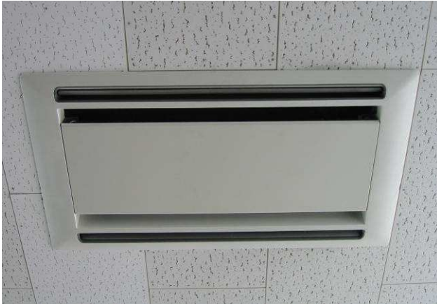
写真 3-1 天井埋込カセット形 （2方向吹出し）
