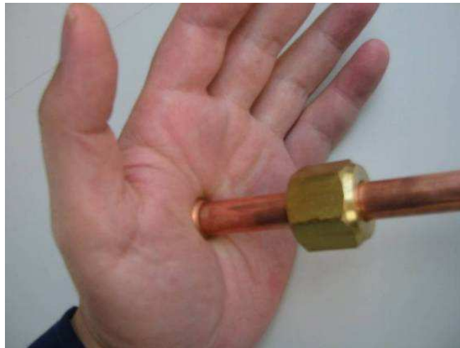
写真 5-11 フラッシング
