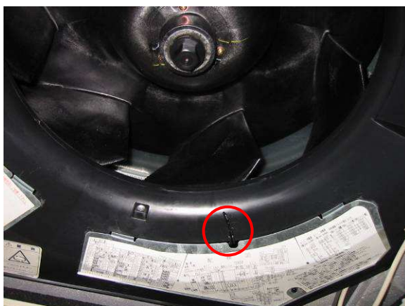
写真 13-6 吸込サーミスタの取り付け位置の例
