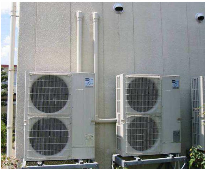
写真 5-16 化粧カバー施工例
