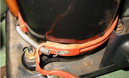
写真 6-1 クランクケースヒータ
