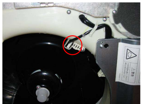
写真 13-6 吸込サーミスタの取り付け位置の例
