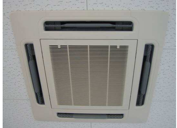
写真 3-2 天井埋込カセット形 （4方向吹出し）
