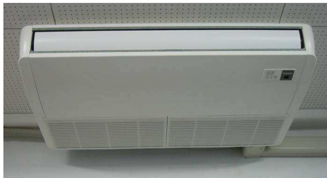
写真 3-3 天吊形エアコン写真
