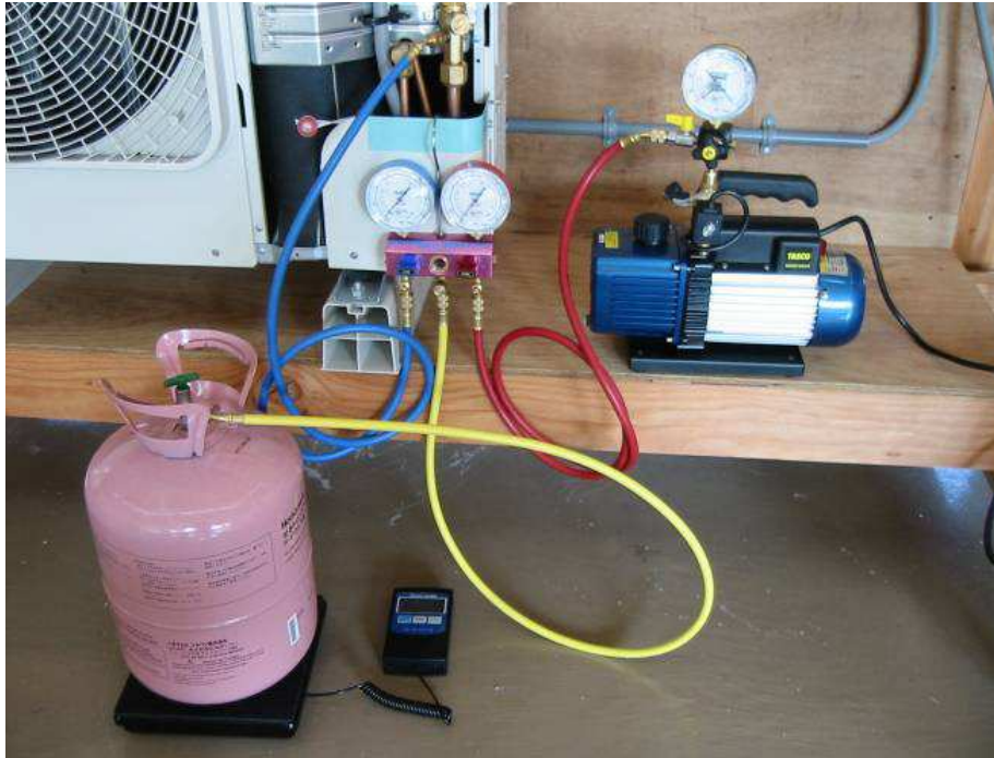
写真 7-1 冷媒充填時の接続例
