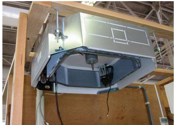
写真 13-5 ファンを外した後の室内機
