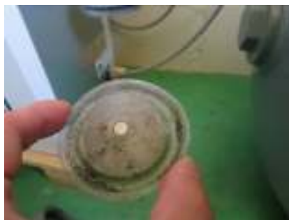
目詰まり状態
