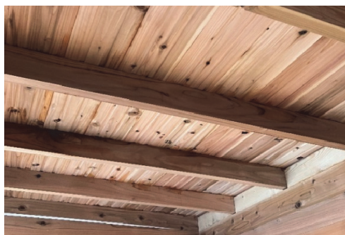
図4 内部から見える野地板
