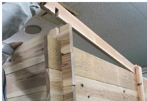
図2 カフェ板による壁の組立て
