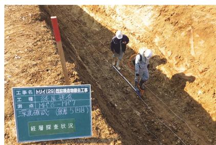
図6 掘削坑内での経層探査
