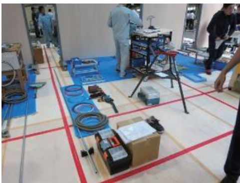
図 18 作業開始前の状態
