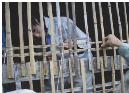
図3 下地材・竹使用の小舞壁組み
