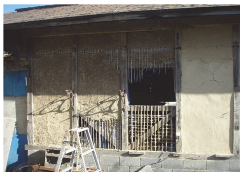
図5 屋外にある農作業用建物の修復作業
