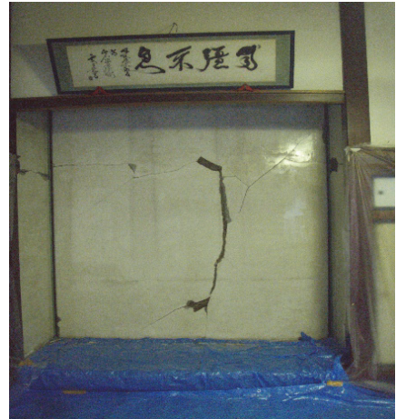
図 8(a) 古民家母屋床の間内壁 下塗り
