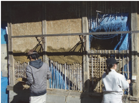
図 6(a) 古民家・屋外作業蔵外壁修復作業の様子
