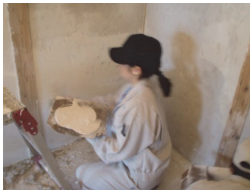
図2 内装施工実習での漆喰塗り練習
