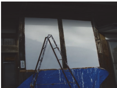
図 7 母屋外壁修復 上塗り完成
