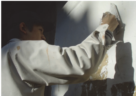
図 6(b) 上塗り修復作業
