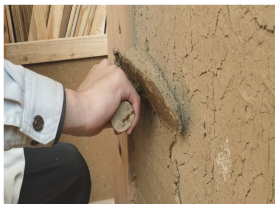
図12 漆喰壁中塗りコテ作業
