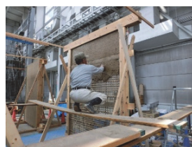
図16 荒壁補修
