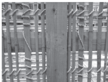
図4 民家用真壁試験体小舞揺き
