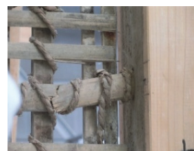
図12 折損した間渡し竹
