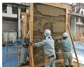
図9 剥離部分の除去
