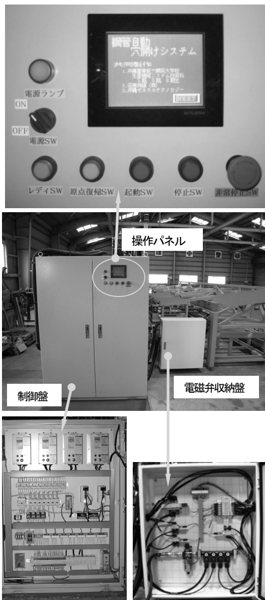
図12 制御部の構成
