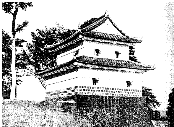
図3 解体修理前の旧二ノ丸隅櫓
