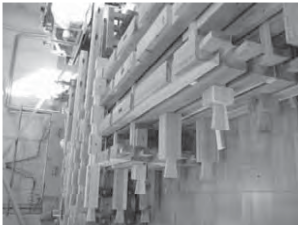
図 30 木歩道橋の 3 列構成の平組み
