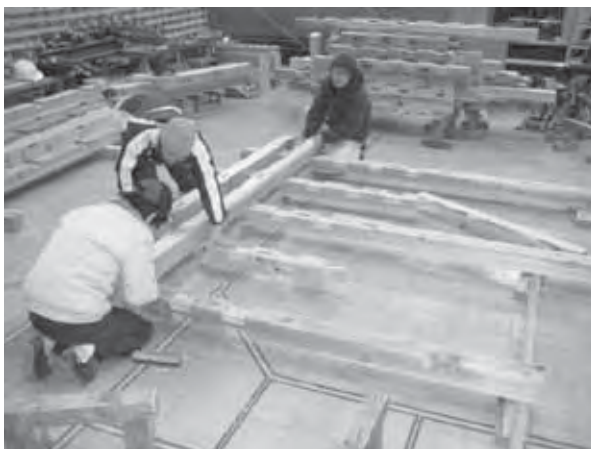
図 28 仮組みにおける接合部の嵌合度の確認
