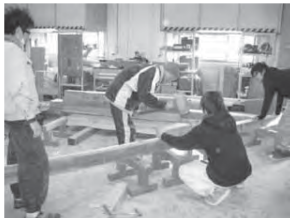
図 27 職人による追掛け大栓継ぎの組立指導
