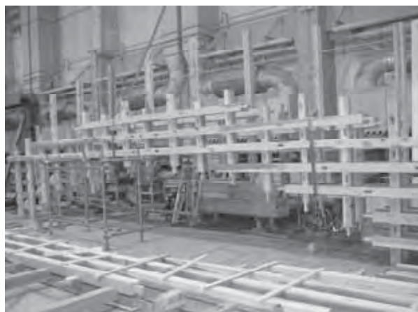
図 31 木歩道橋の 2 列構成の仮組み
