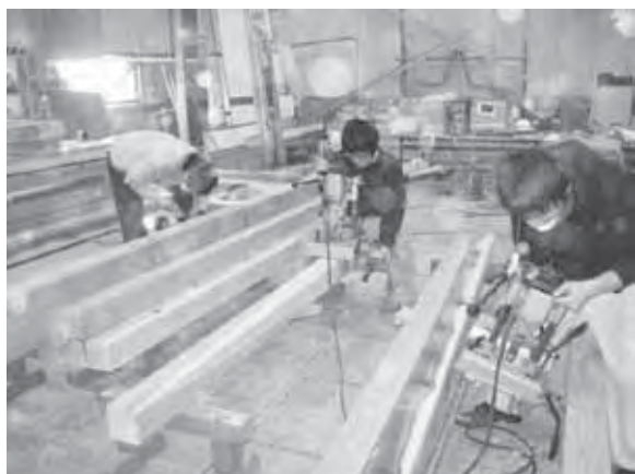
図 24 梁部材の流れ作業の加工状況
