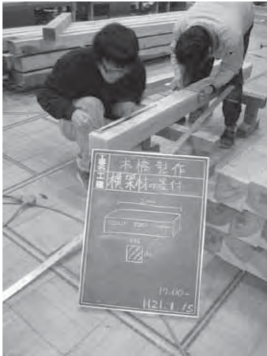
図 20 横架材の墨付け作業
