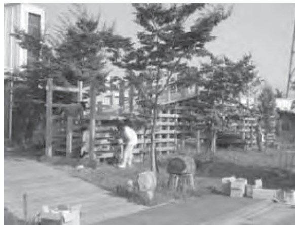
図39 木歩道橋の塗装作業
