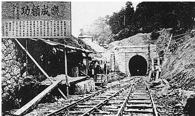
図4 . 逢坂山トンネル工事風景 (交通博物館提供)
