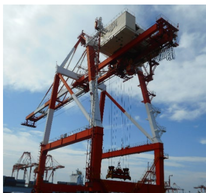
図 54 実機訓練で使用したガントリークレーン
