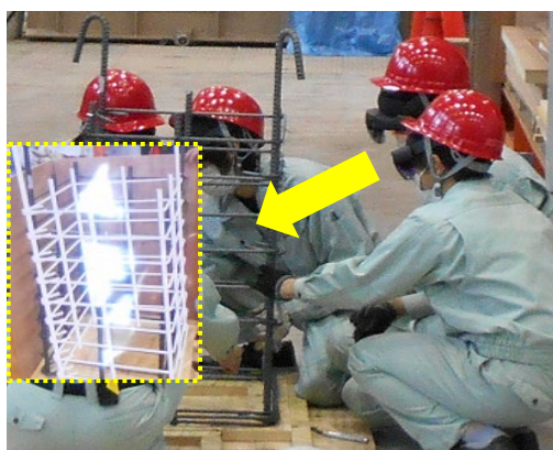
図 35 MR グラスを装着し、配筋作業
