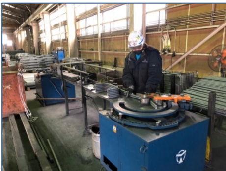
図3-13 鉄筋加工実習
