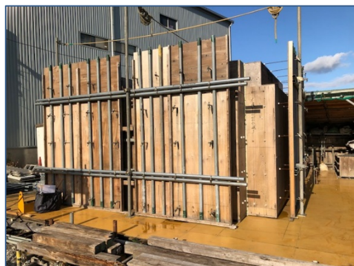
図3-10 型枠施工実習
