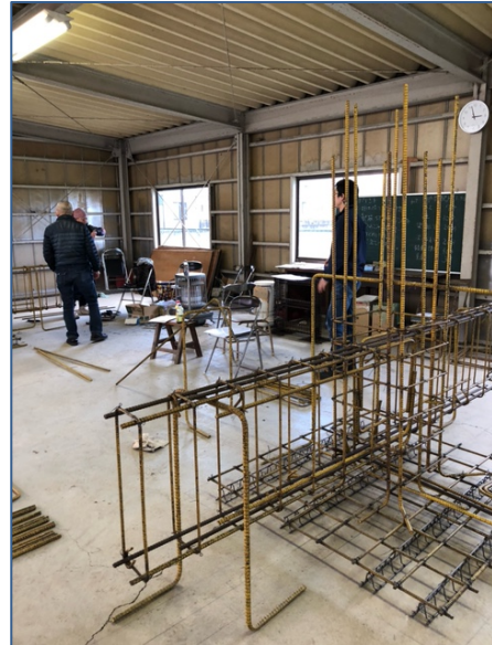
図3-8 鉄筋コンクリート施工科 (鉄筋加工、組み立て：実習)
