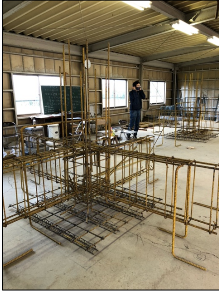
図3-7 鉄筋コンクリート施工科 (鉄筋加工、組み立て：実習)
