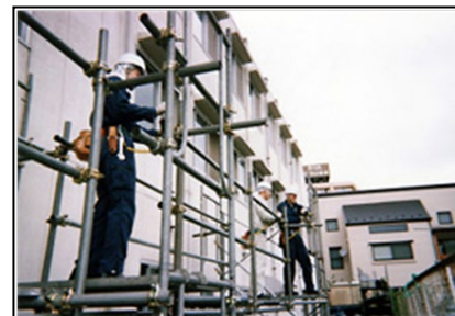
図3-6 単管足場架設実習
