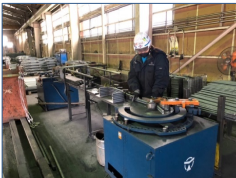
図3-13 鉄筋加工実習
