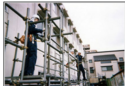
図3-6 単管足場架設実習
