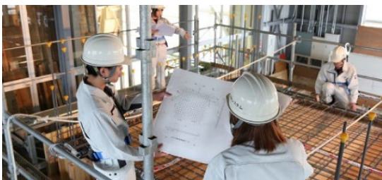
図3-2 鉄筋配筋実習
