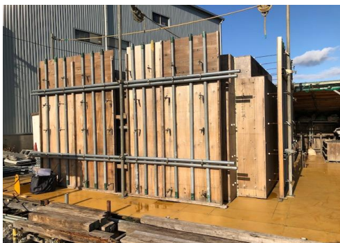
図 1.2 (株)マルチビルダー高等職業訓練校 型枠実習
