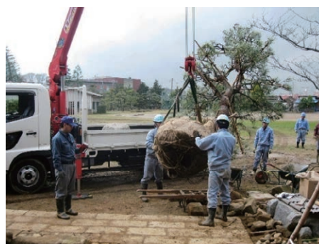
b 植栽実習(移動式クレーン、根巻き他)
