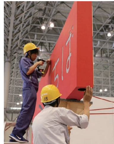
図 2-24 CEATEC JAPAN 現場設営
