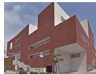
図 2-11 城東職業能力開発センター
