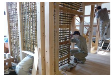
図2-16 壁下施工実習
