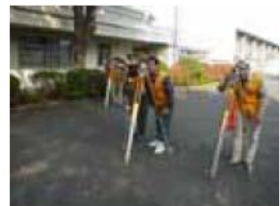
図 2 - 3 1 道路縦横断の測量
