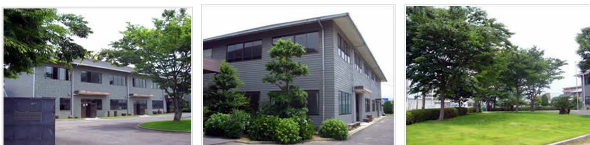
図2-7 INAX 建築技術専門校の外観（左：A棟、中：B棟、右：中庭）
