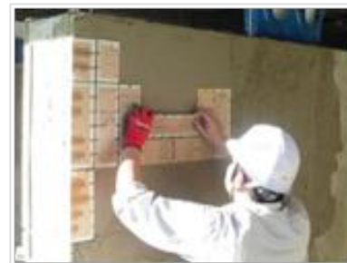
図2-9 タイル施工実習
