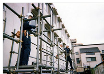
図 2-22 単管足場架設実習
