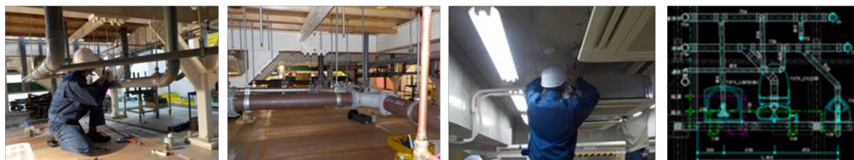
図 2-14 左 2 枚（吊り配管実習）、中（空調配管）、右 CAD 図面
