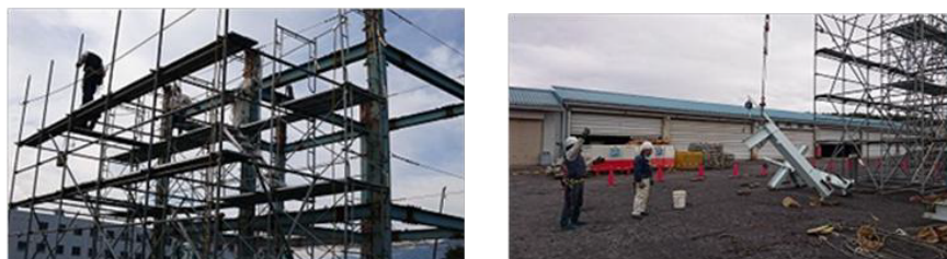
図2-23 鉄骨昇降用外部足場架設(右:クレーン利用)
