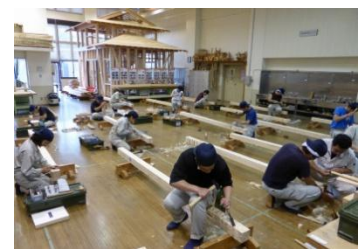
図2-15 継手・仕口実習
