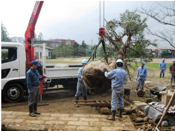
植栽実習（松の木の移植） 根巻き、掘り取り作業 移動式クレーンによる移動、植栽
