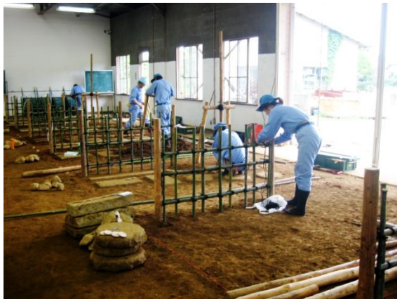
造園実習 四つ目垣の製作 基本作業は、一人で作業します。
