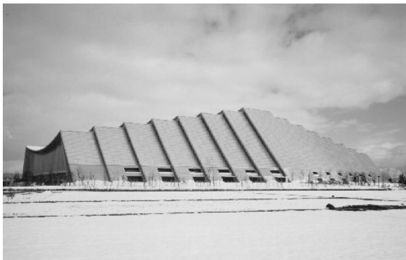
長野市オリンピック記念アリーナ（集成材と鋼板の半剛性吊屋根）
