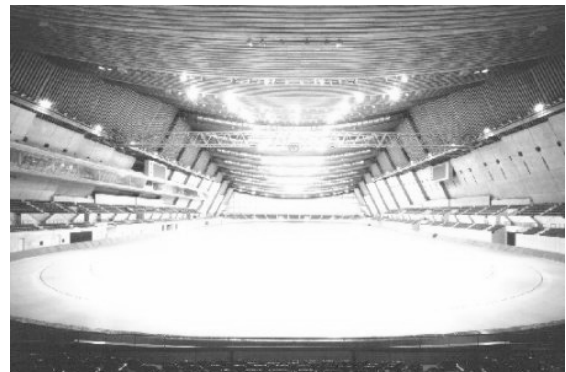
長野市オリンピック記念アリーナ（集成材と鋼板の半剛性吊屋根）
