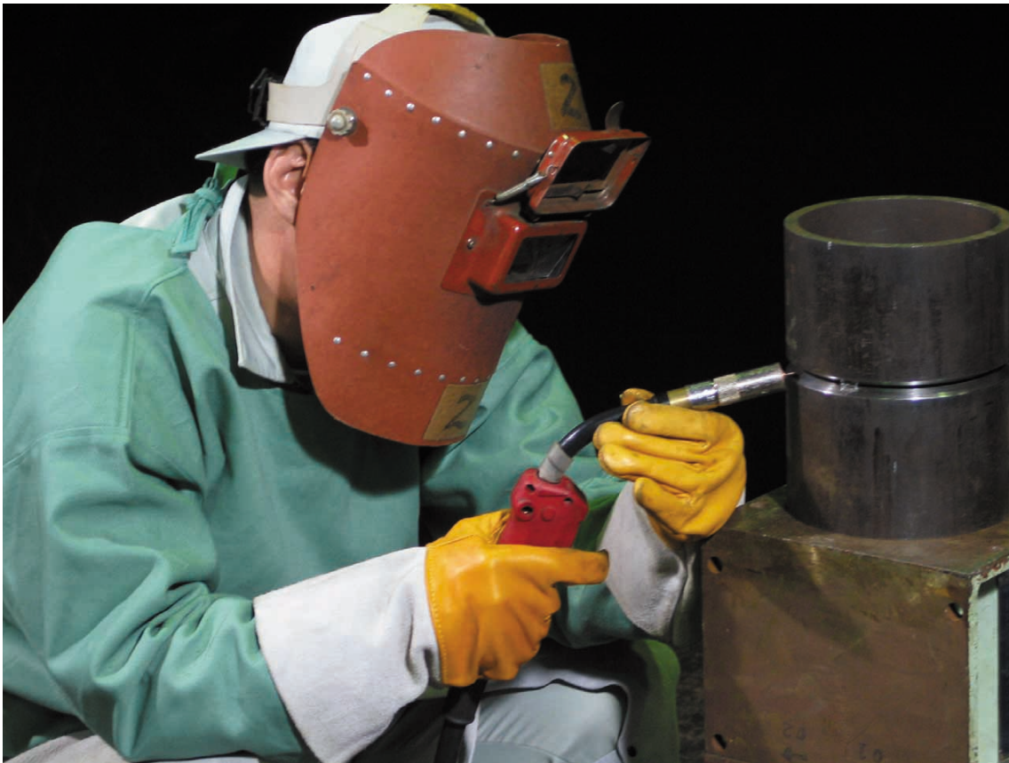
図6 - 101 管の横向き姿勢溶接におけるトーチ角度の状況
