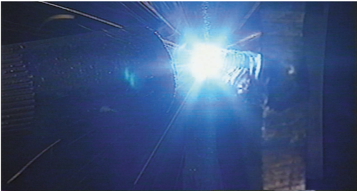
図 6 - 131 高度熟練技能者の 9 mm 板横向き姿勢後退法 3 層目 2 パス目溶接のトーチの状況
