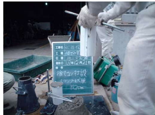
写真 4 - 6 スランプ試験
