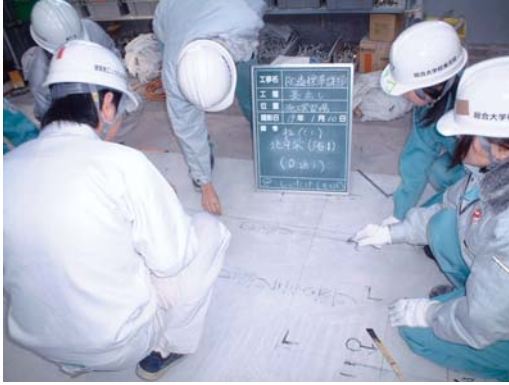
写真4-7 捨コンへの墨出し
