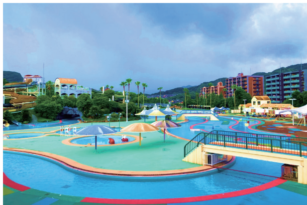
図1 アドベンチャープールの概観
